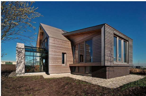
Hout en glas, ondergeschikt baksteen
